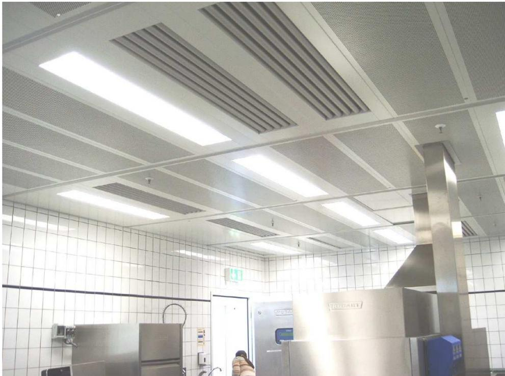
Die Aufgabe von Küchenlüftungsdecken ist je nach Einsatzort sehr unterschiedlich. Im Bereich von Spülküchen liegt neben der Aufnahme von Luftdurchlässen, Sicherung der Hygiene und Aufnahme der Beleuchtung der Schwerpunkt auf der Reduzierung des Schallpegels bzw. der Nachhallzeit.
