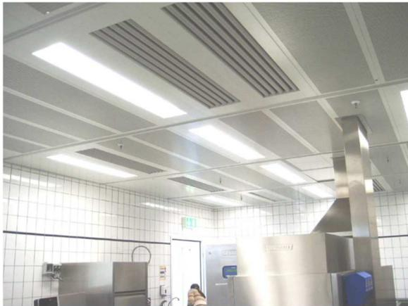
Die FLEX-LINE Akustik System-Lüftungsdecke besteht aus beschichtetem Aluminium oder Edelstahl welches ein Lochbild (28% freier Querschnitt) besitzt. Die akustische Wirksamkeit erfolgt über einen geschlossenzelligen Polyethylen-Schaumstoff niedriger Dichte und ist speziell für Anwendungen geeignet, bei denen Kontakt mit Feuchtigkeit oder Nässe auftreten kann.
