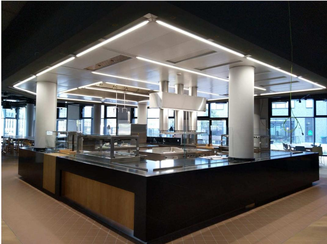
Die Düsenplattenabsaugung (1-Rohr, 2-Rohr oder 3-Rohr) ermöglicht eine unmittelbare Absaugung an der Entstehungsstelle und wird dadurch im Gegensatz zu Hauben Lösungen nicht von Querströmungen beeinflusst.
